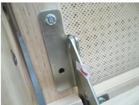
Soporte metálico de refuerzo
