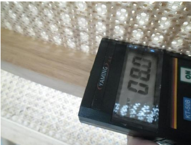
Control de humedad en travesaño
