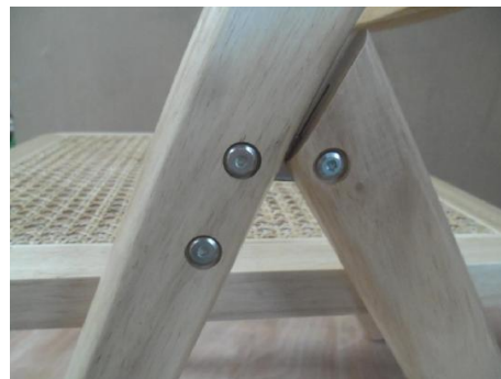
Tornillería en uniones de madera
